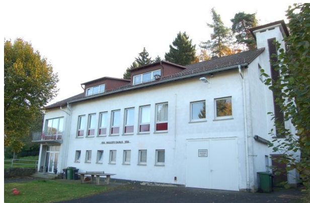
Im Obergeschoss des DGH befinden sich der Saal, im Erdgeschoss die Räume der Freiwilligen Feuerwehr.
